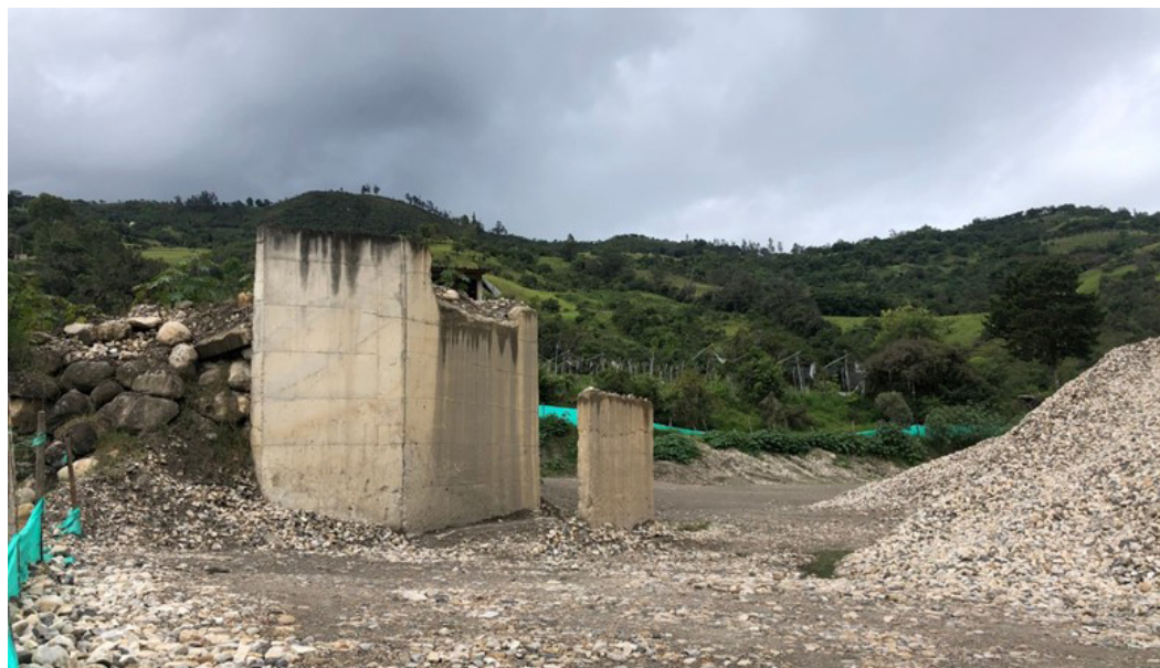
FIGURA 4. INFRAESTRUCTURA U OBRA EN ESTADO DE ABANDONO Y PILAS DE MATERIAL EN SECTOR CUENCA RÍO SERVITÁ, MUNICIPIO DE CONCEPCIÓN
