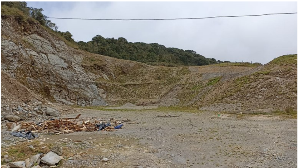
FIGURA 3. SUELOS DESPROVISTOS DE COBERTURA VEGETAL, PÉRDIDA DE COBERTURA VEGETAL Y SITIO POTENCIAL DE APORTE DE SEDIMENTOS EN EL SECTOR ALTO DE GUACA
