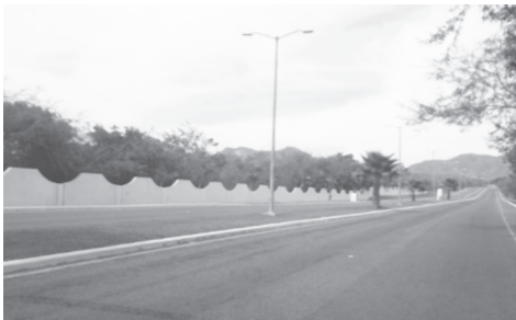
Figura 3. Muro perimetral del CIP Litibú
